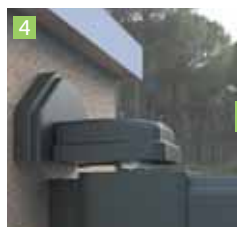
4 Pivot haut fixé par une équerre en aluminium et cache en aluminium de la couleur du portail.
